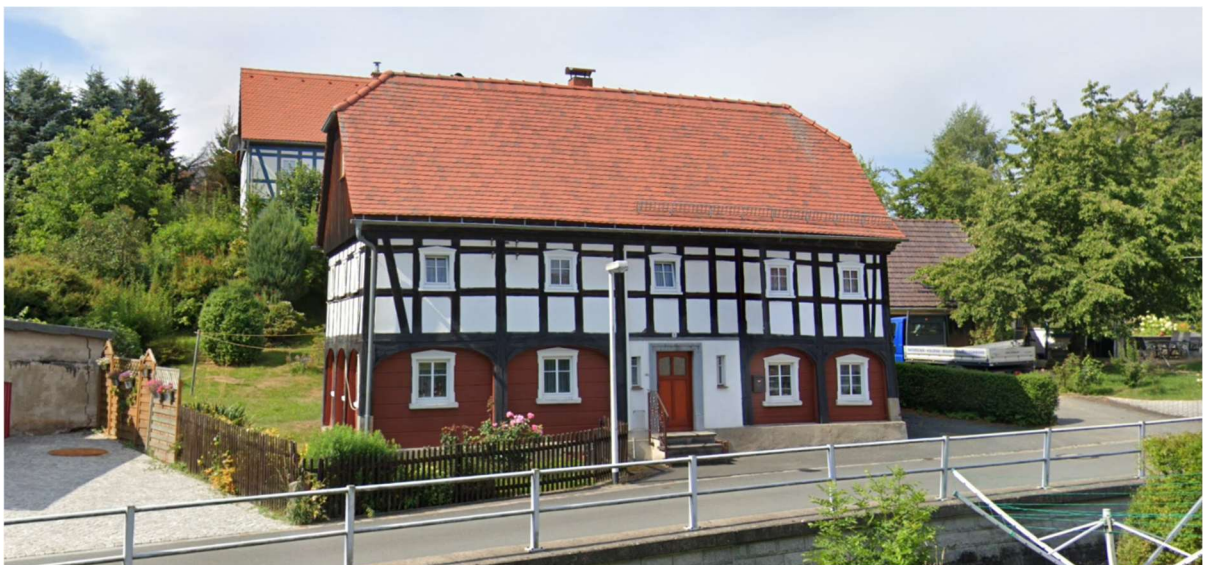
Abbildung 12 | freistehendes Fachwerkhaus (Baujahr vor 1918)
