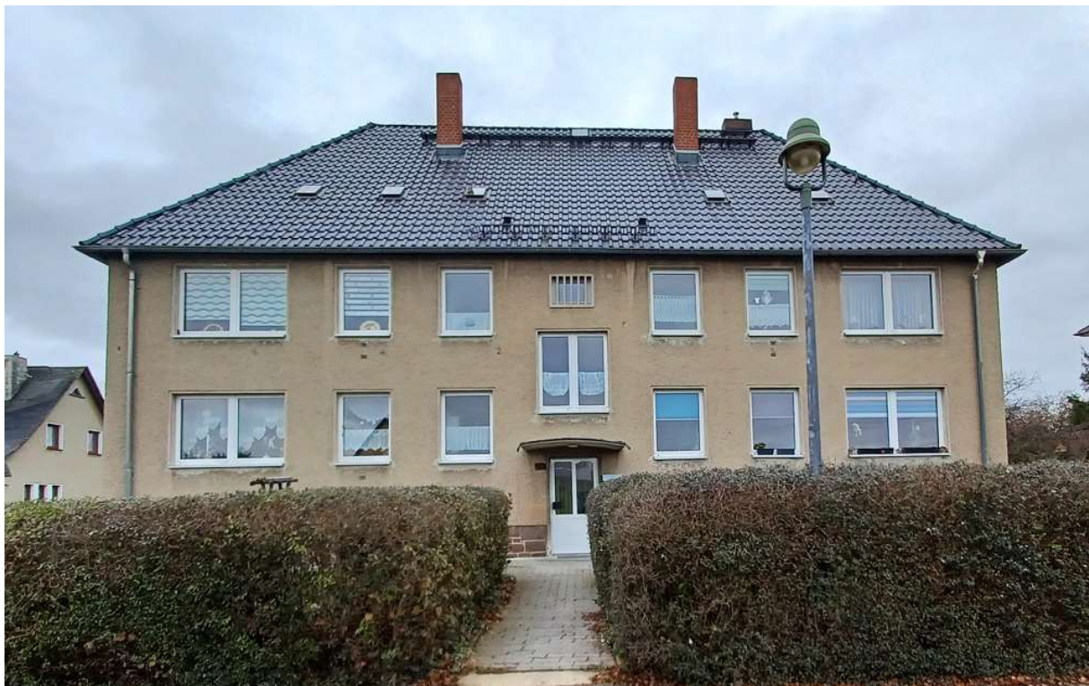
Abbildung 17 | Mehrfamilienhaus um 1960 mit erneuerter Dacheindeckung
