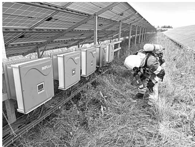
Brennender Wechselrichter
