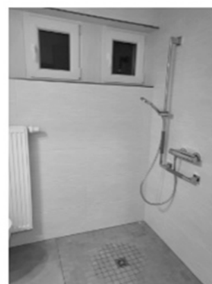
Sanierung: Einbau Fenster & barrierefreie Dusche
