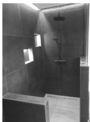
Neubau: begehbare Dusche mit Ablagefächern
