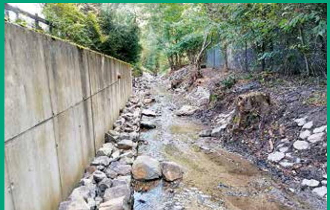
Hochwasserschadenbeseitigung am Eckartsbach in Oberseifersdorf
