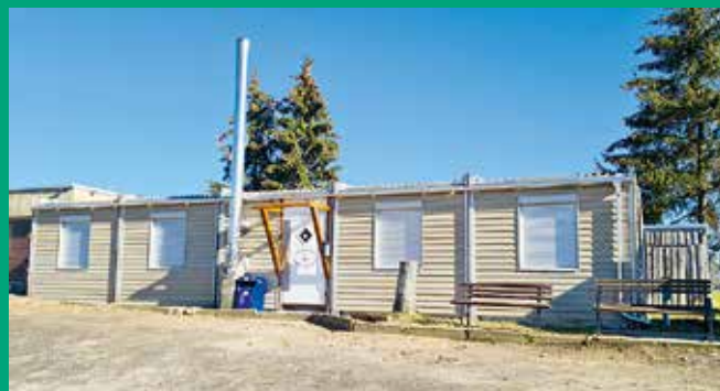
Sanierung Vereinsgebäude Jugend- und Kulturverein Oberseifersdorf e. V.
