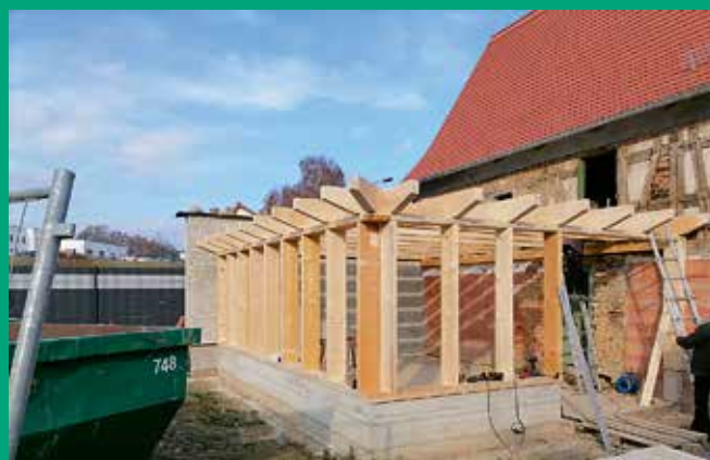
Sanierung „Alte Lotte“ in Eckartsberg, Anbau Rückseite
