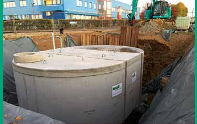
Errichtung Löschwasserzisterne im Gewerbegebiet Oberseifersdorf
