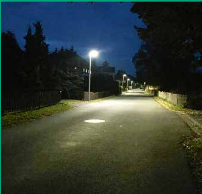
LED-Umrüstung der Straßenbeleuchtung in Mittelherwigsdorf
