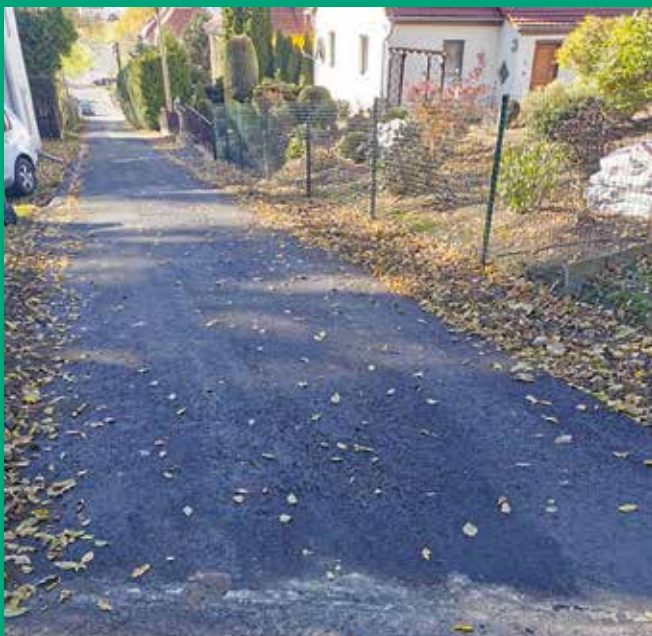
Straßeninstandsetzung Alte Gasse in Eckartsberg
