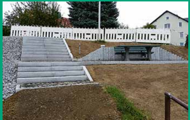
Ersatzneubau Fußgängertreppe an der Neuen Straße in Eckartsberg
