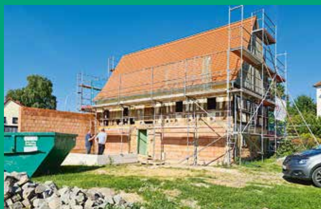
Sanierung „Alte Lotte“ in Eckartsberg
