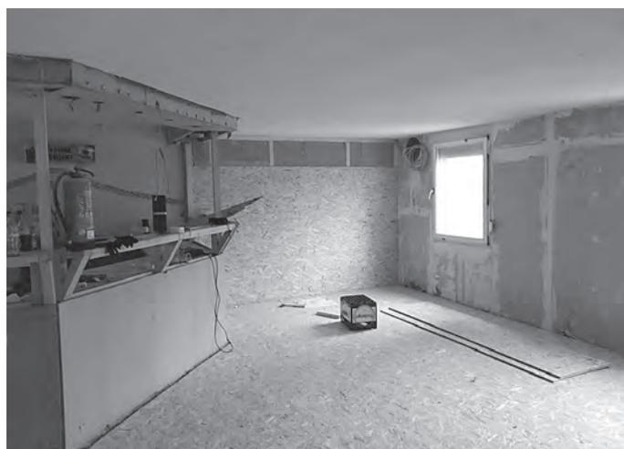
Inzwischen wurden in den Oberseifersdorfer Vereinscontainern alle notwendigen Abrissarbeiten abgeschlossen. Wir konnten bereits mit dem Aufbau neuer Trockenbauwände und eines neuen Fußbodens beginnen.
