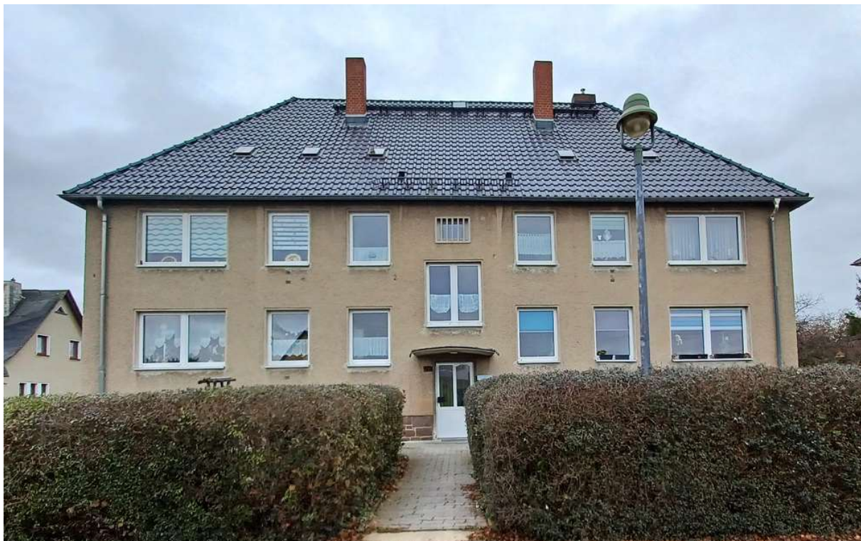
Abbildung 17 | Mehrfamilienhaus um 1960 mit erneuerter Dacheindeckung
