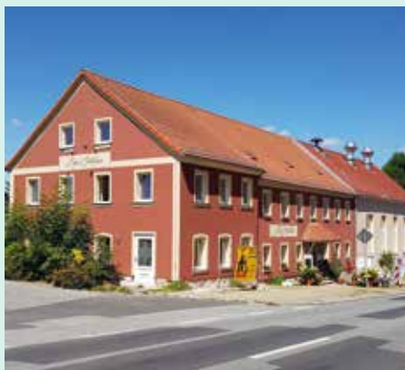
Barrierefreier Zugang noch in Arbeit
