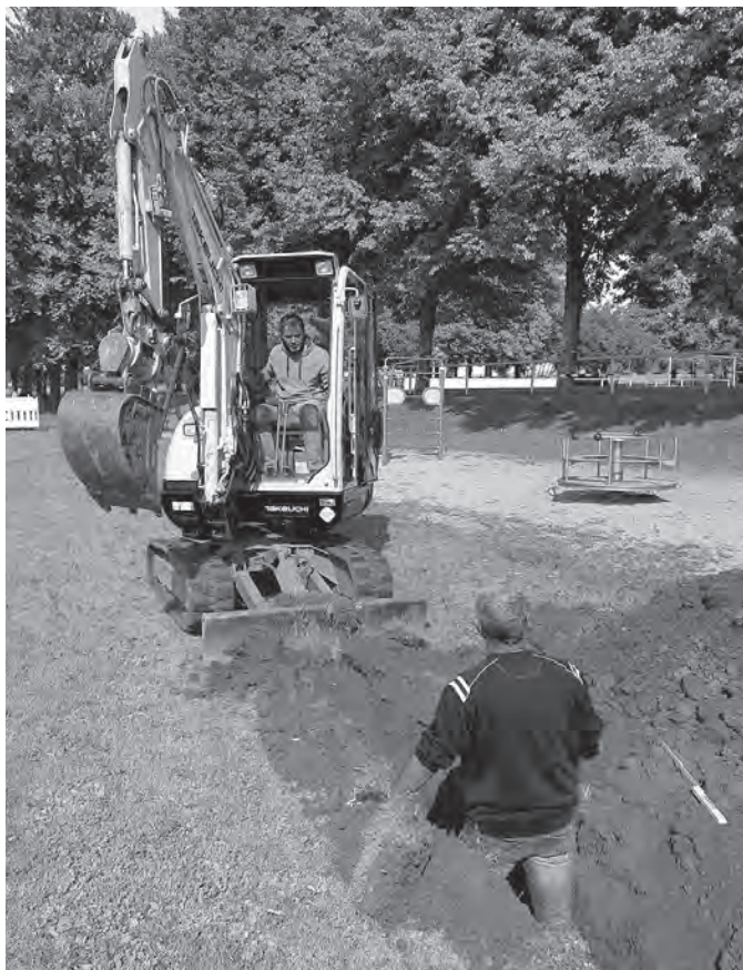
Thomas Lange (vorn) und Baggerfahrer Steffen Lindner von der SG Rotation Oberseifersdorf heben einen Graben für die Elektrokabel der neuen Flutlichtanlage am unteren Sportplatz aus. Dabei stoßen sie auf Munition aus dem Zweiten Weltkrieg. (Foto: Thomas Christmann)
